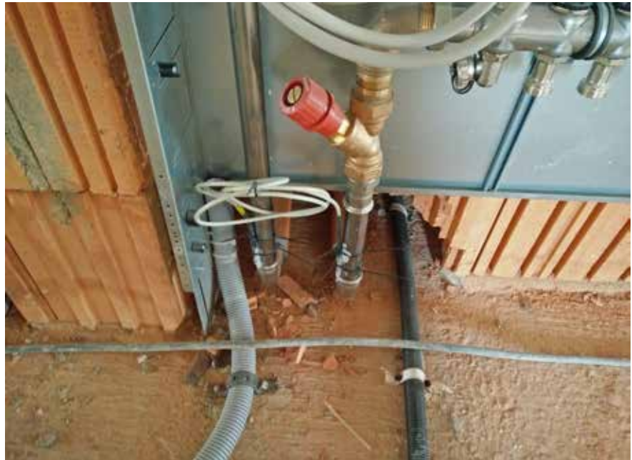
Abbildung 10 Messung der Vorlauftemperatur (Fotoquelle: © Lehrstuhl ENPB, TU München)
