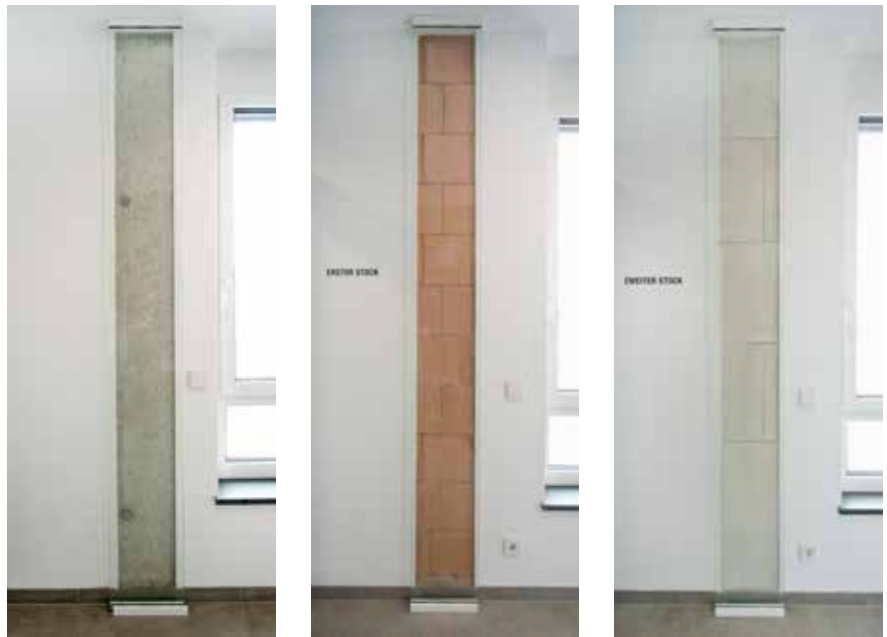
Abbildung 2 Die verschiedenen tragenden Materialien der Außenwände (Fotoquelle: © Bauer | bauerwerner.com)
