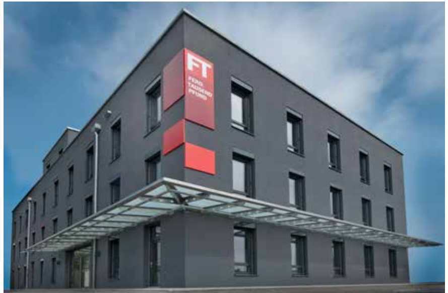
Abbildung 1 Der Neubau Bürogebäude Tausendpfund (Fotoquelle: © Bauer | bauerwerner.com)
